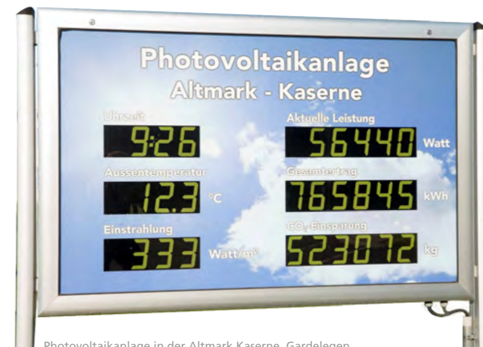
Photovoltaikanlage in der Altmark Kaserne, Gardelegen
