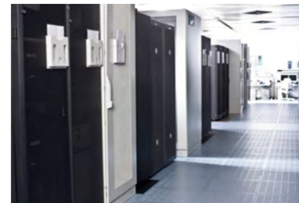
Energieeffizienter Aufbau eines Serverraums
